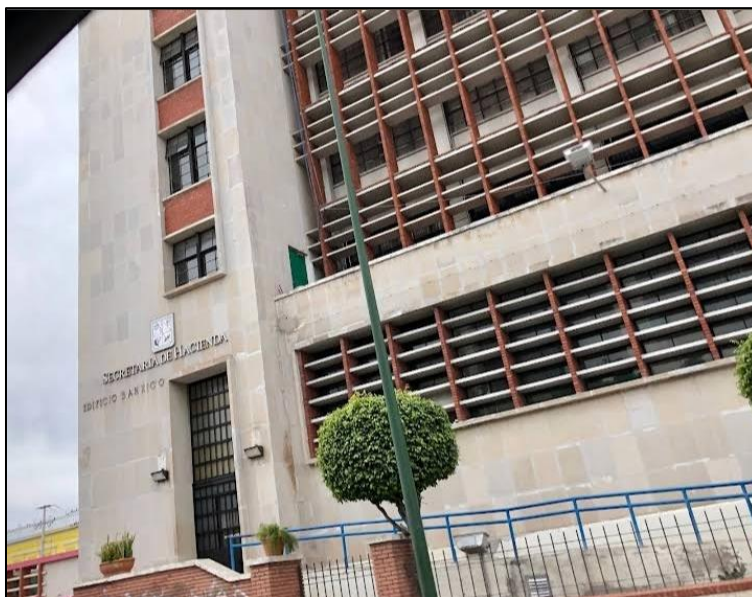
Entrada principal al Edificio Banxico, con rampa de acceso.
